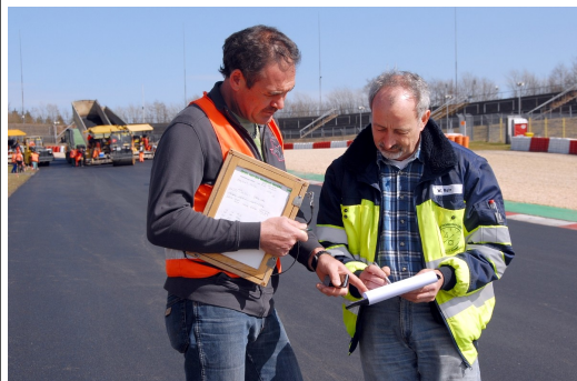
Bild 2: Ständige Qualitätskontrolle während der Einbauarbeiten auf dem Nürburgring: Physiker Wolfgang Rahn (rechts) vom Labor Hart aus Neuwied erläutert dem Einbaumeister Manfred Esper von der Kölner Bauunternehmung Von der Wettern GmbH während der Einbauarbeiten die aktuellen Messergebnisse. So können selbst minimale Abweichungen sofort ausgeregelt werden.
